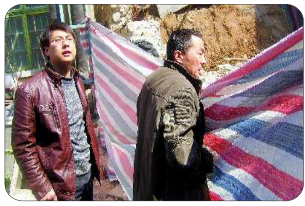
↑小区居民透过“篷布围墙”忧虑地看着挖掘机施工。
