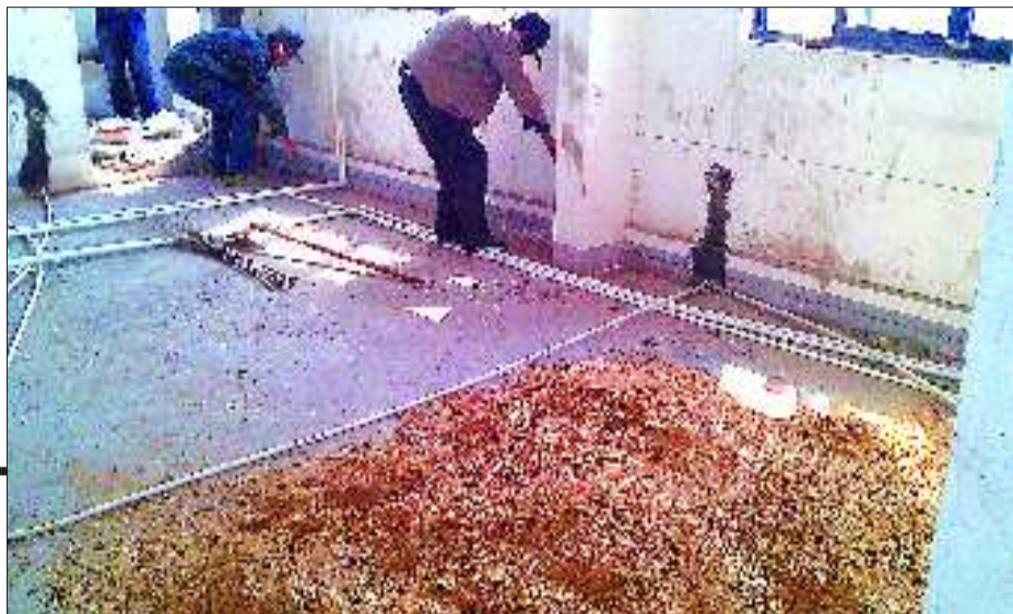
▶3月28日,一座楼的19层正在进行装修施工。
