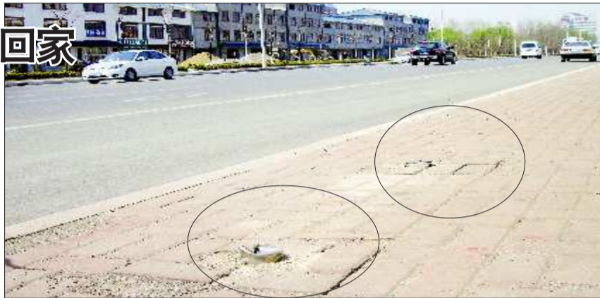
站牌的两条腿已经被齐根截掉,只剩下几厘米高。 记者 洪英摄
