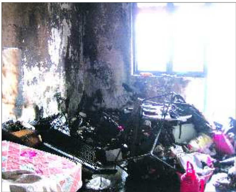
起火房间内被烧得面目全非。 本报记者 王若松 摄
