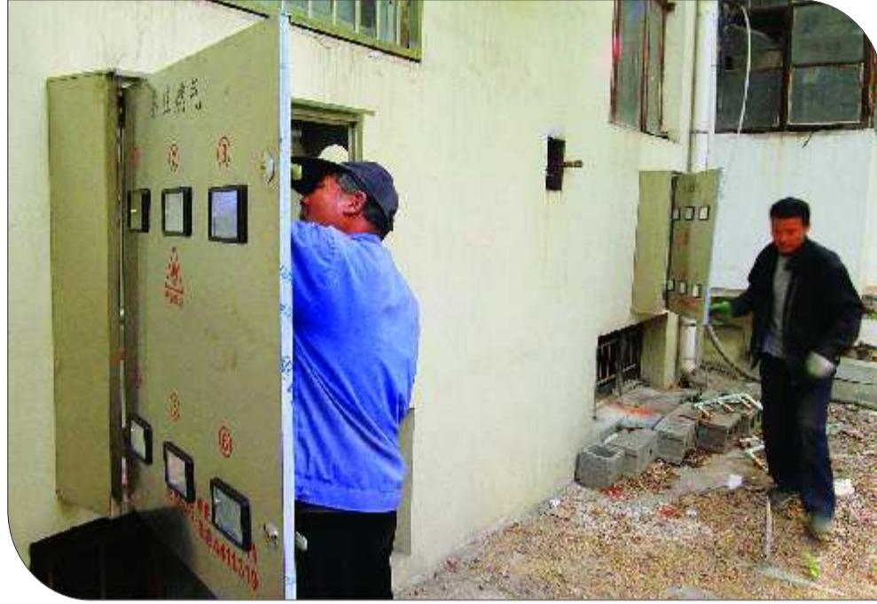
20日，燃气改造施工队两名工人正在给立新小区13号居民楼安装燃气室外表箱。
