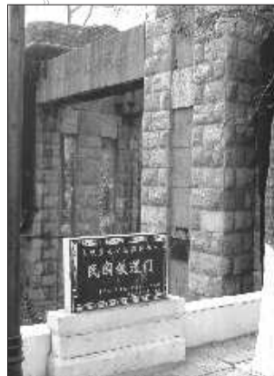
已被拆除的区级保护文物民国铁道门 杨霄 摄
