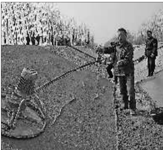
在梁山县黑虎庙镇附近,水利工程施工人员正在修建引黄支渠。 本报记者 马辉 摄
