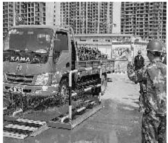
25日在金雀山路东段的一处建筑工地,记者看到,该建筑工地的出入口设置了一个自动喷水平台,此时,一辆运输材料的车辆停靠在平台上,喷水设施从平台前后左右4个方向喷出水流冲洗车轮胎。只用了2分钟的时间,轮胎已经光洁如新,不带走一点泥土。
