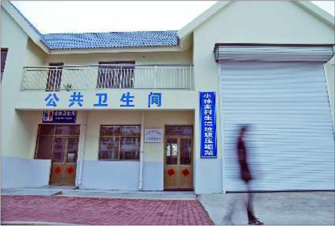
位于秦楼街道小孙家村的日照首个公厕压缩站。 本报见习记者 张照朋 摄
