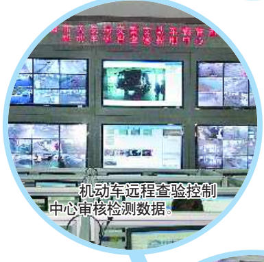
机动车远程查验控制中心审核检测数据。
