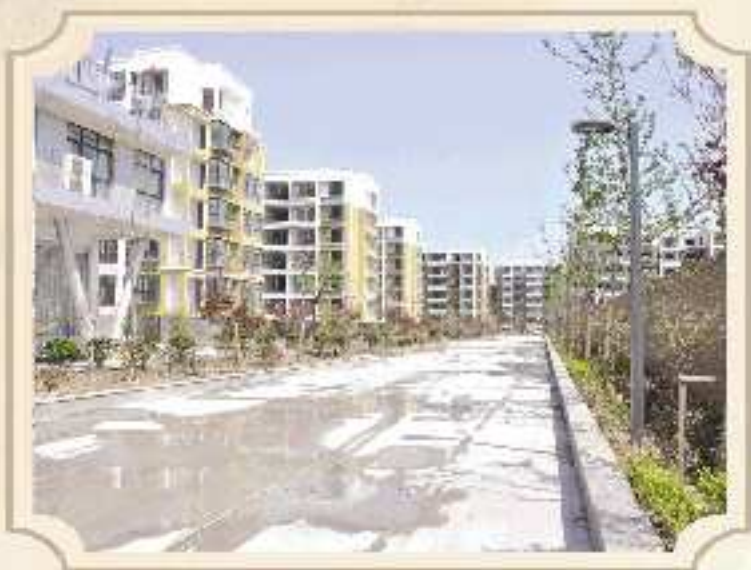
小区道路和景观绿化初步完成。
