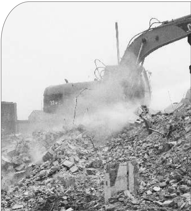
市中区杨河社区拆迁现场,拆迁产生大量烟尘。袁沛民 摄
