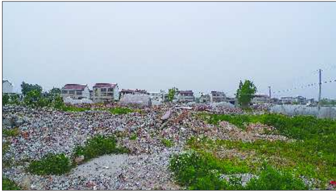
▲马小楠老家的拆迁正在进行中。本报记者 张子森 摄
