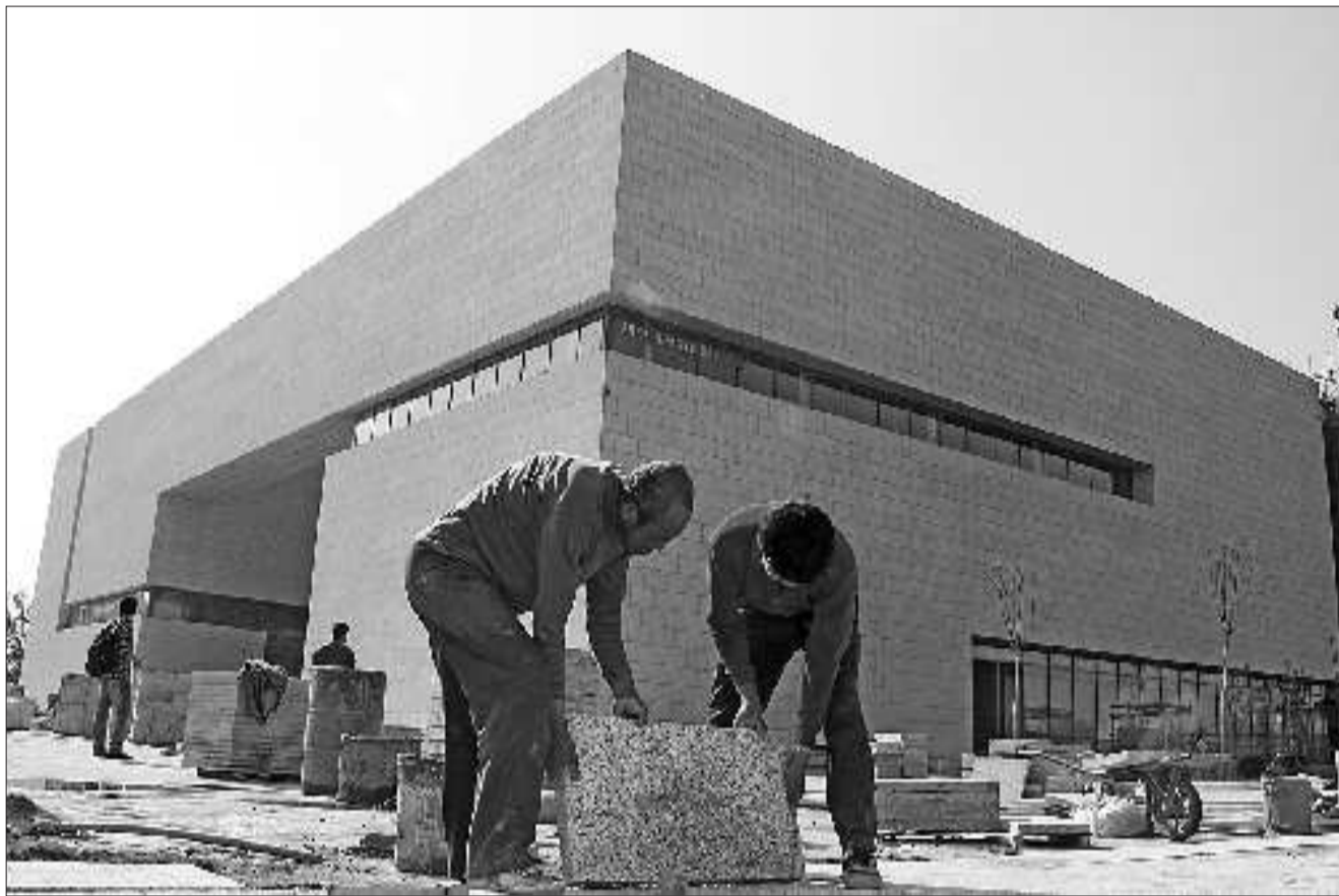
5月16日,施工人员正在铺设广场地砖。本报记者 马志勇 摄
