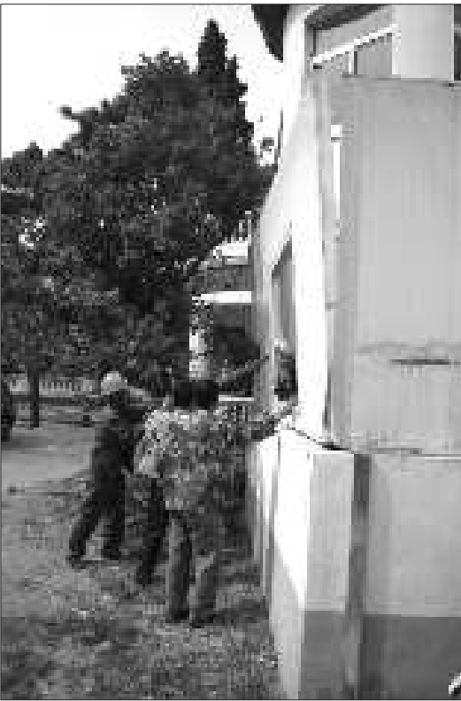
▲工人正在拆除一处板房的墙壁。张杰 摄
