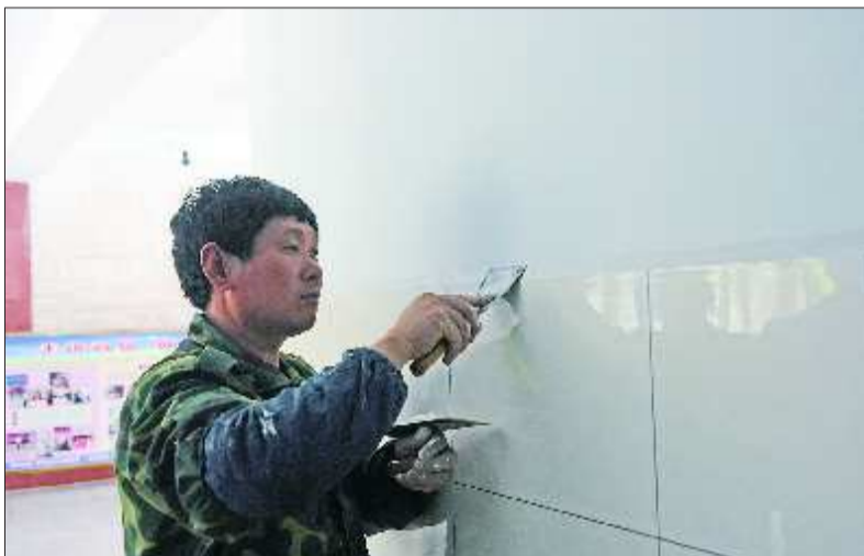
18日上午,东方双语实验学校千佛山校区,校舍加固工程已进入收尾阶段,施工工人正粉刷教学楼墙面。 通讯员 刘强 摄
