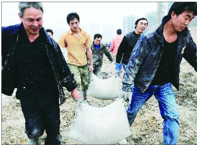
19日上午,事发现场,建筑工人们正在抬沙袋堵溃口。 东方IC供图
