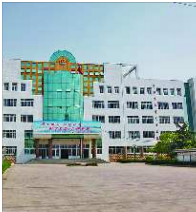
6层楼高的新营中学教学楼暑假就要拆了。
