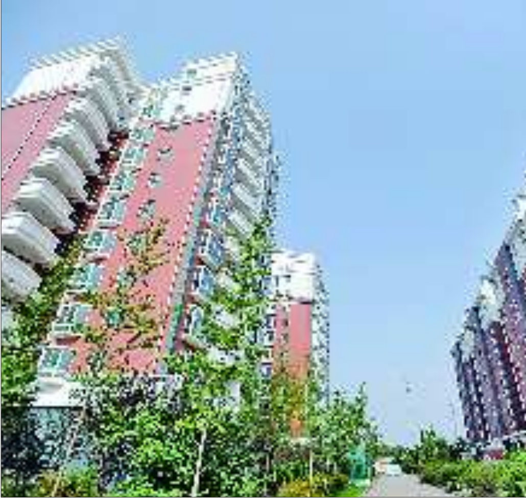
即将作为公租房试点的馨苑小区外景。
