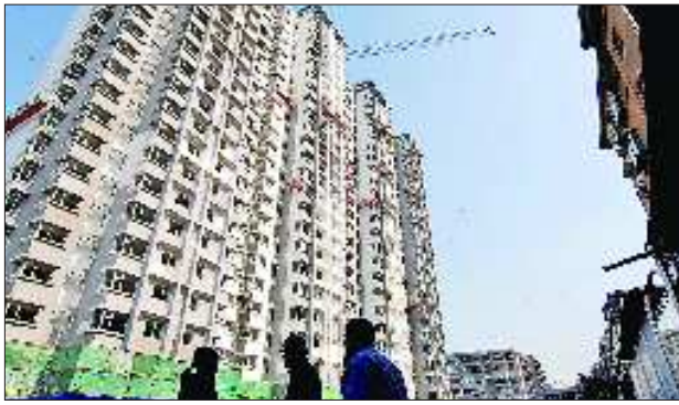
天桥区天成新居的廉租房外景。
