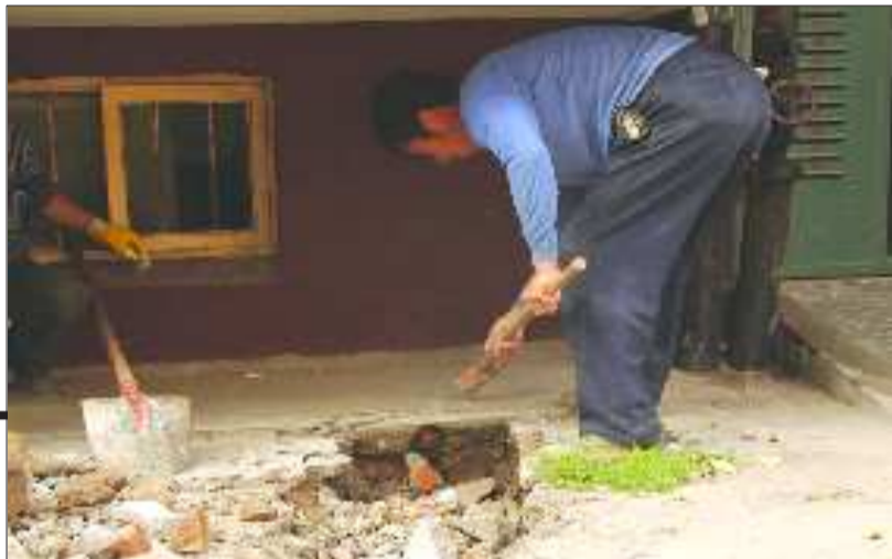
►施工人员在现场施工。钟建军 摄
