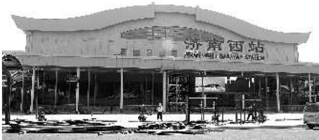
济南西站的西广场已基本完工,这里将来是旅客疏运的主要地方。
