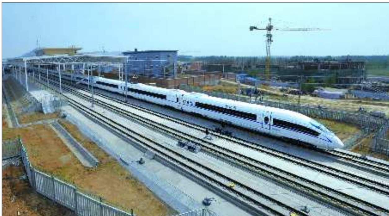
—列高铁列车驶出滕州东站。
