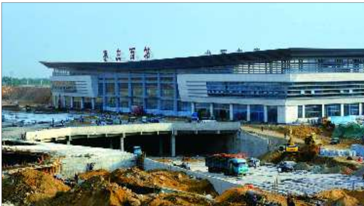
枣庄站的站房主体已经建设完成。根据最终确定的站名,“枣庄西站”将改为“枣庄站”。
