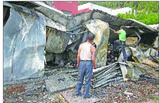
工人正在拆除已经烧毁的板房。 本报记者 刘德峰 摄
