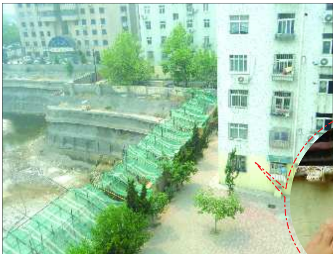
◀工地离居民楼非常近。
