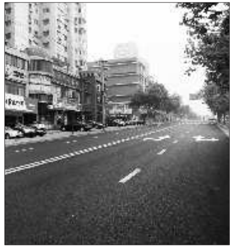
延安三路已铺设好新的路面。本报记者 宋珊珊 摄
