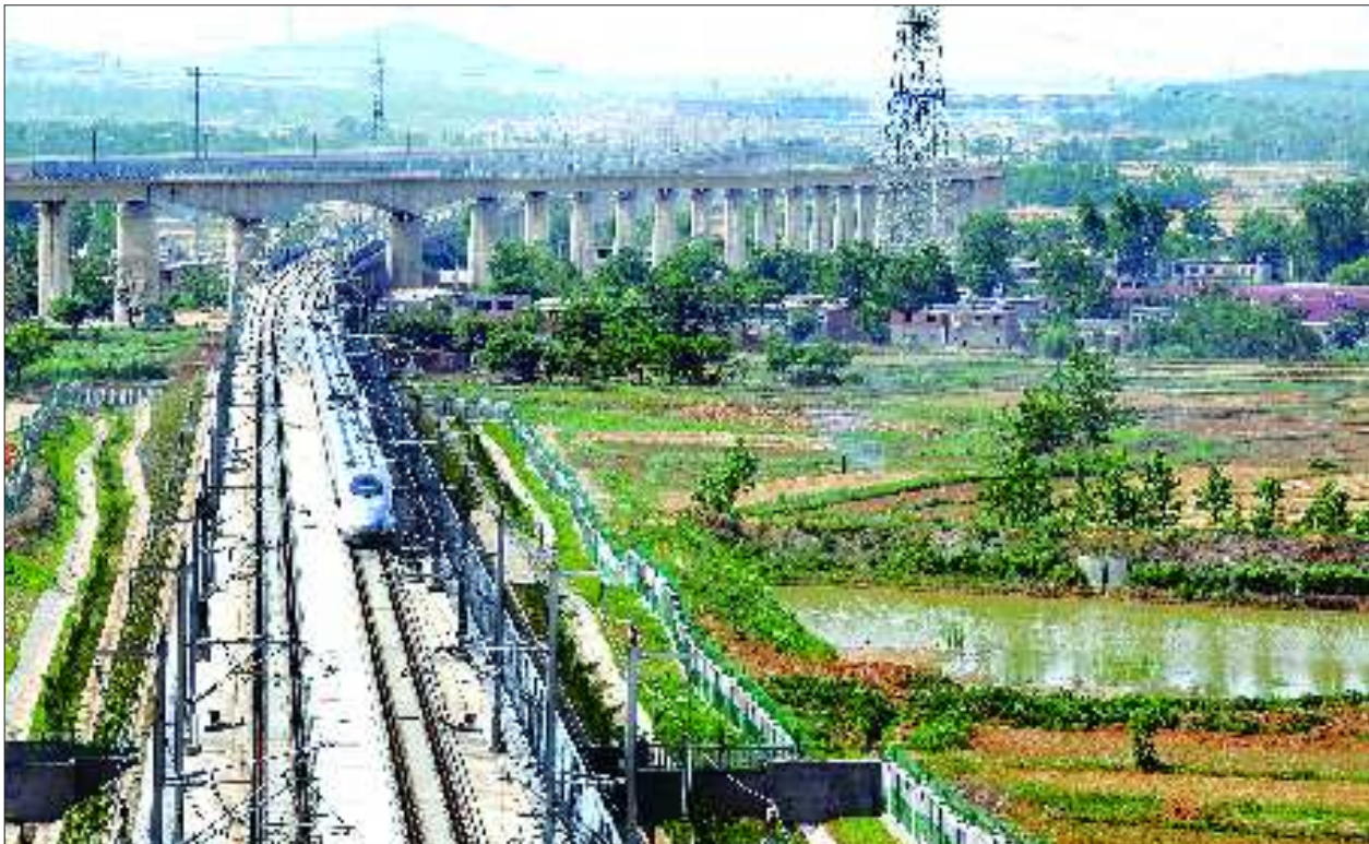
高铁从蚌埠南站驶出,穿过正在铺设轨道的至合肥城际高铁驶入西芦山隧道。本报记者 张中 摄
