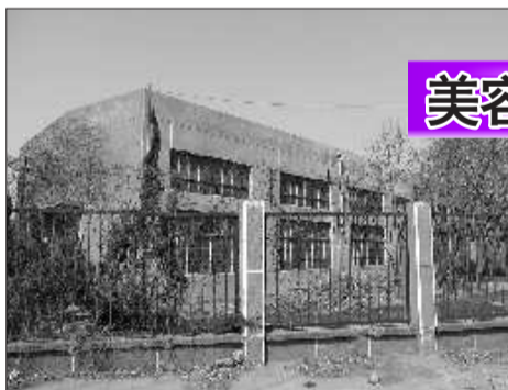
泰能热电铁路沿线厂房现状
