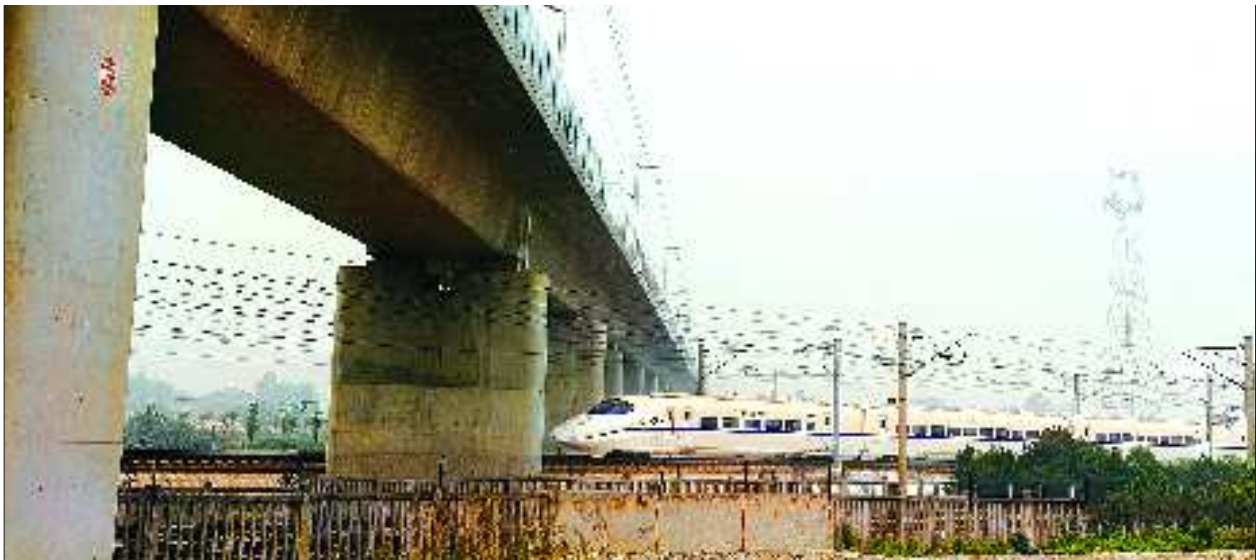
记者历尽艰辛抵达镇江与丹阳交界处的千里村,此处是新老京沪线的交叉口。
