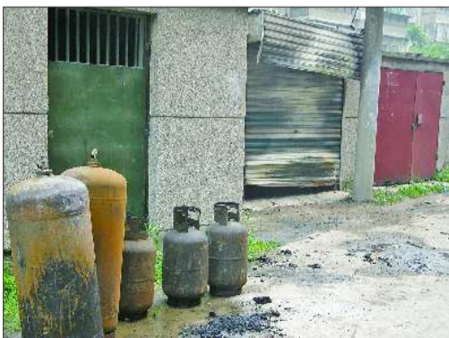
储藏室的卷帘门已经被烧得变形。 本报记者 王倩 摄
