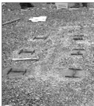
2005年夏天,我国施工人员和外国技术人员共同摸索,为“永久性路面”埋设传感器等仪器设备。(资料图)
