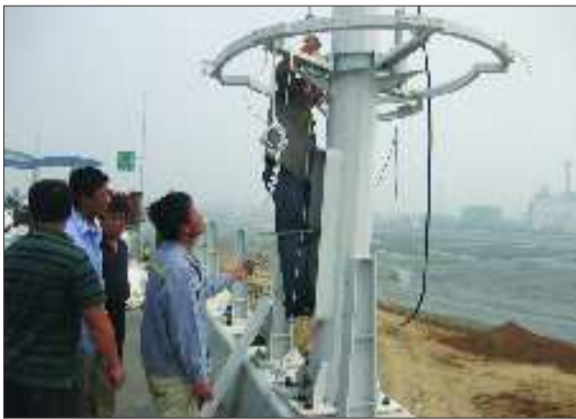
胶州湾大桥上,工人们正在安装路灯。
