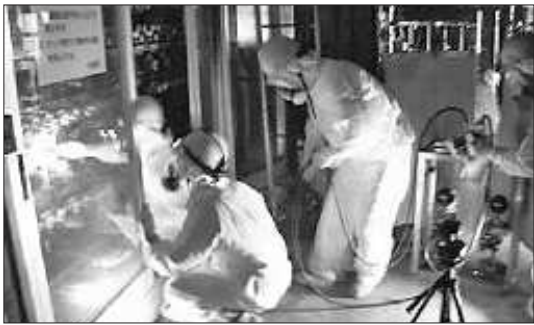
日本工人在核电站内抢险作业。(资料片)
