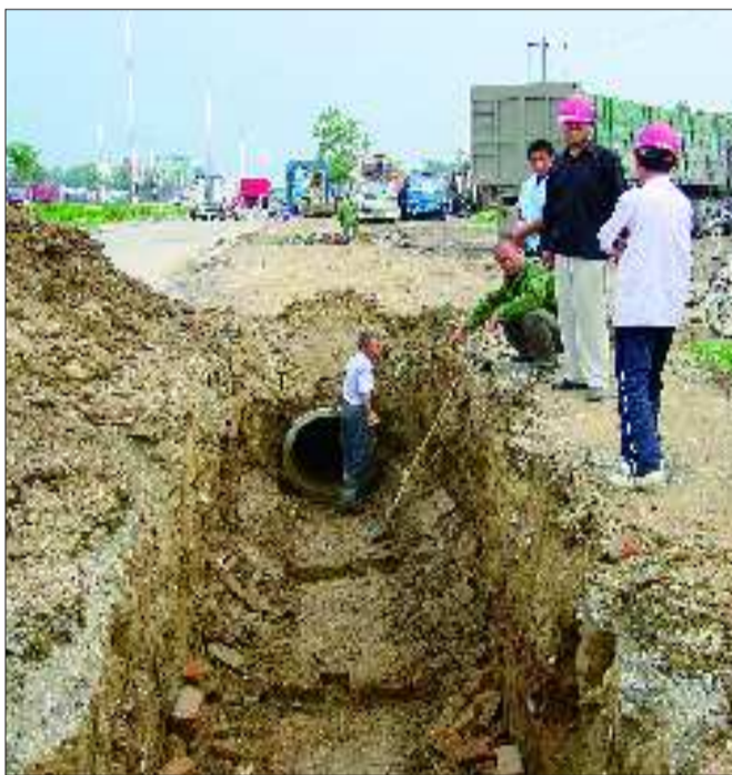
复兴街的管道正在维修中。本报记者 马瑛 徐乐静 摄
