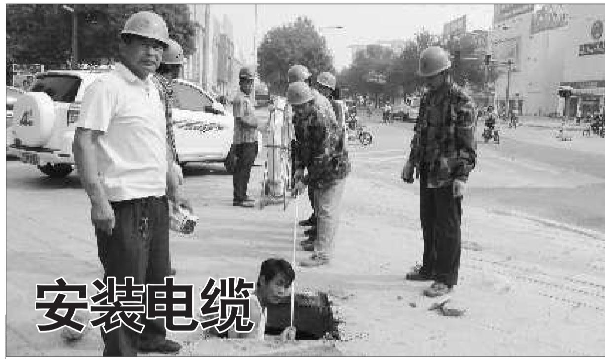
7月4日,在滨州市黄河三路与渤海七路交界处的大观园门口,几名工人正在施工。据现场施工人员介绍,他们是在安装路灯的电缆。
