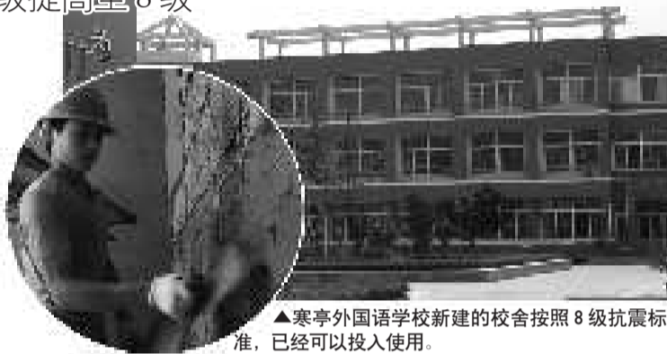
▲在寒亭实验小学,可以看到墙上都被扎上了网状的钢筋,并抹上混凝土。
