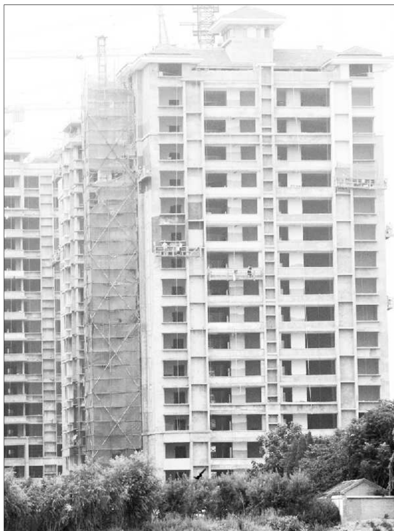
向阳路上一处正在建设的楼盘。 本报记者 李军 摄
