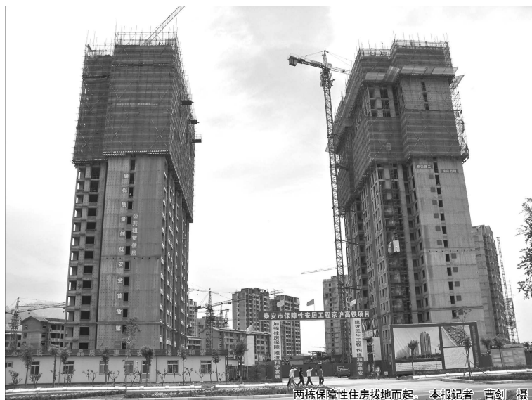
两栋保障性住房拔地而起 本报记者 曹剑 摄
