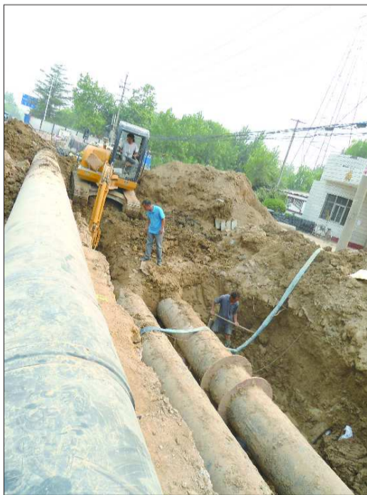
►为确保工期，工人正对解放街支线管道加紧施工。 李凤仪 摄
