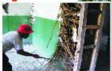
工人在拆除内部破旧隔墙。 周青先 摄
