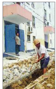
施工人员正在挖沟,进行自来水户表改造。
