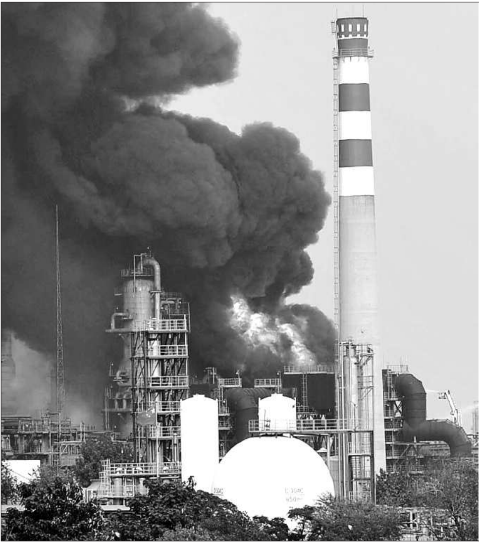
7月16日拍摄的中石油大连石化公司火灾现场。 新华社发
