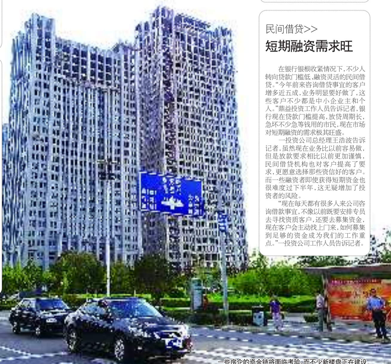
一些房企的资金链将面临考验,而不少新楼盘正在建设。
