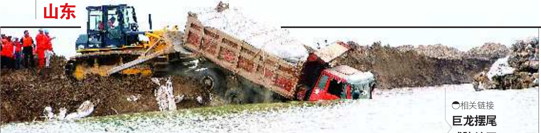
在黄河截流工程中,施工方把装有抛填物的卡车推入河中才成功截流。
