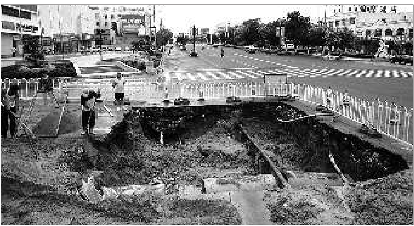
19日,高密市政工作人员正加紧抢修被压塌的马路。 本报见习记者 李小凯 摄
