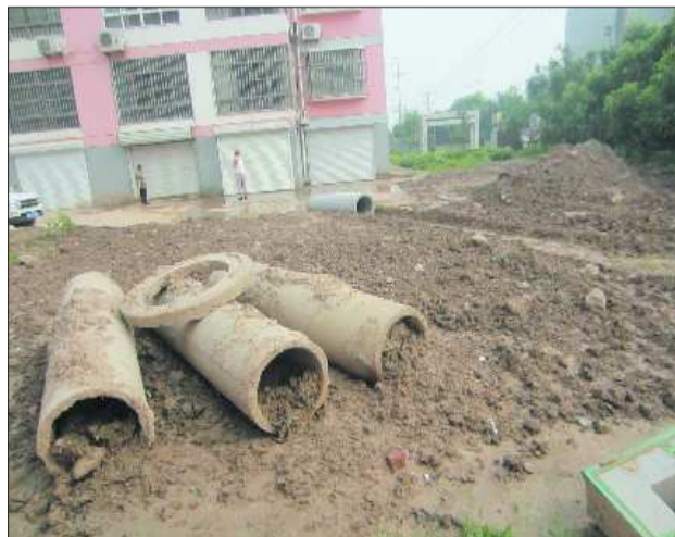
被挖出的排污管线。记者 张卫建 摄
