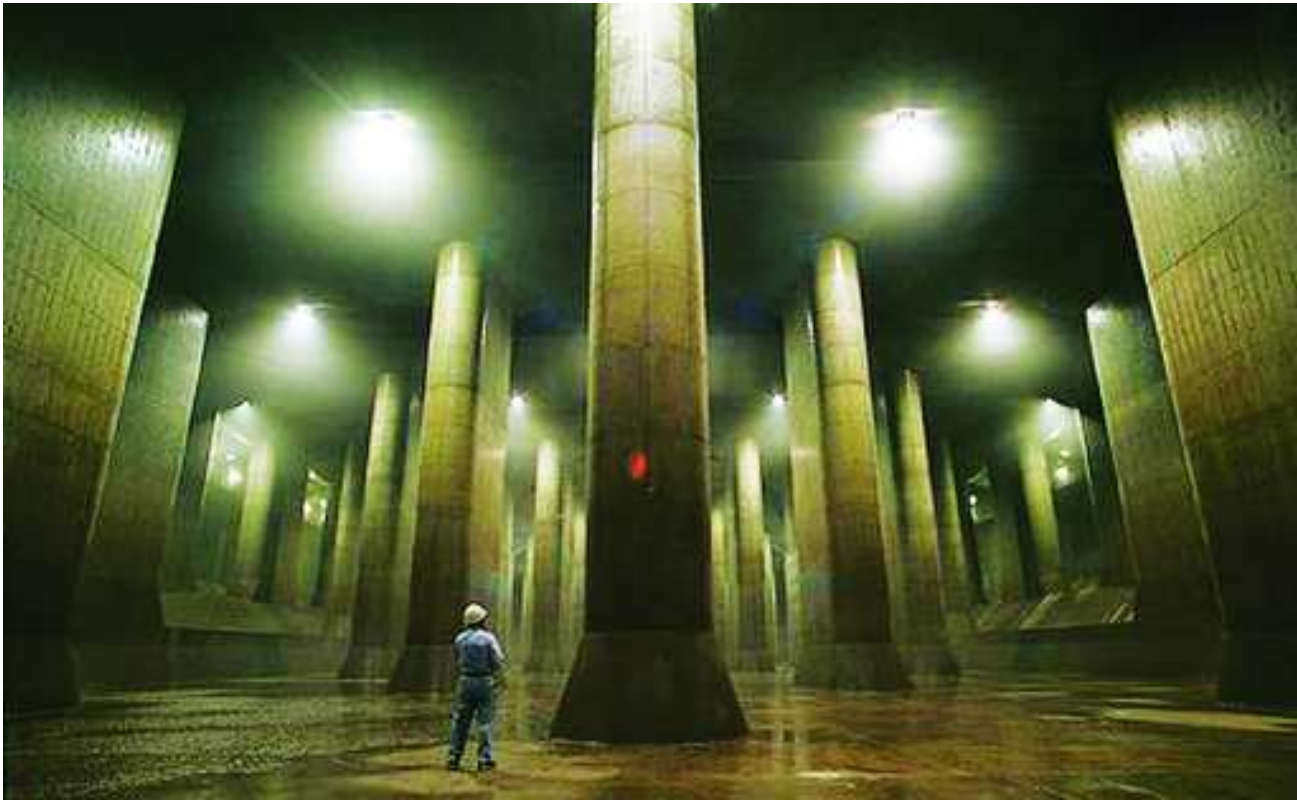
日本地下排水系统的一连串混凝土立柱。
