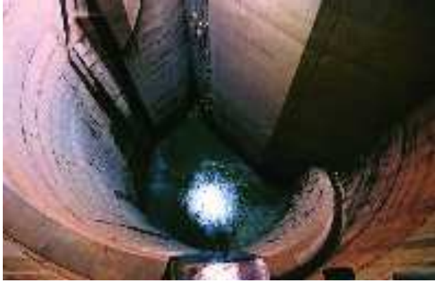
日本的雨水调整池。
