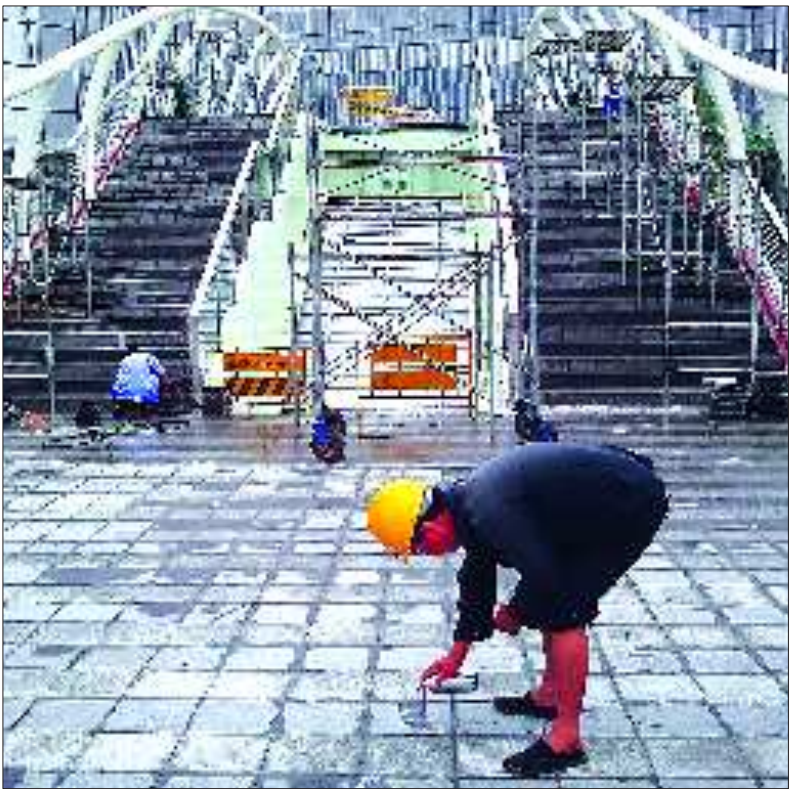
在恒隆广场过街天桥上，施工人员正在进行桥体装饰。实习生 张孝东 寇敏芳 摄
