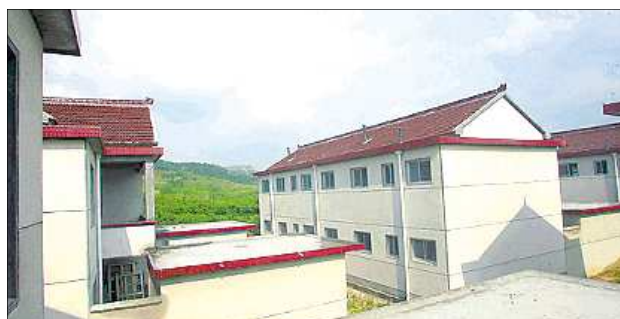
▲正在建设中的新楼房。
