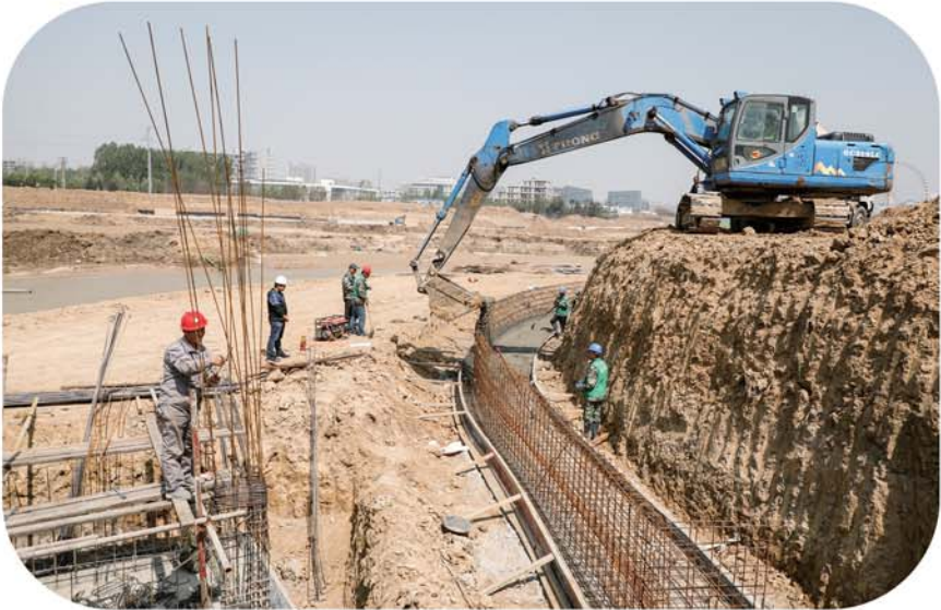
◀鸿雁湖正在施工中。
